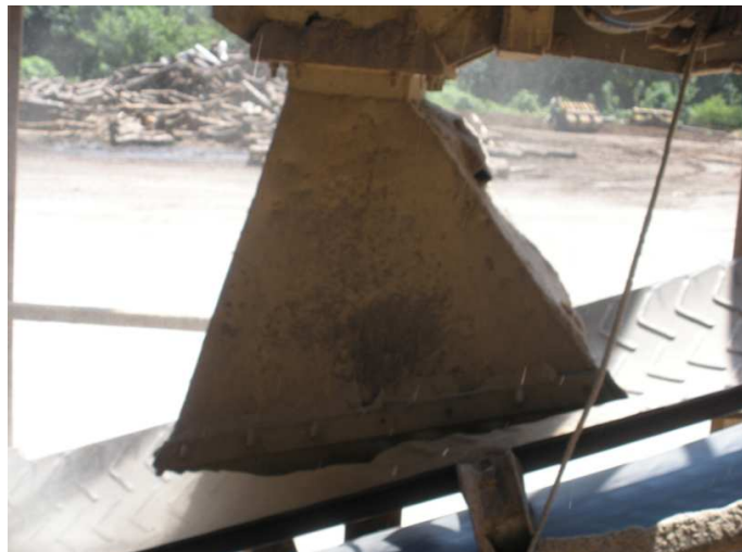
Ilustración No. 14 Transporte del chip al silo de almacenamiento
