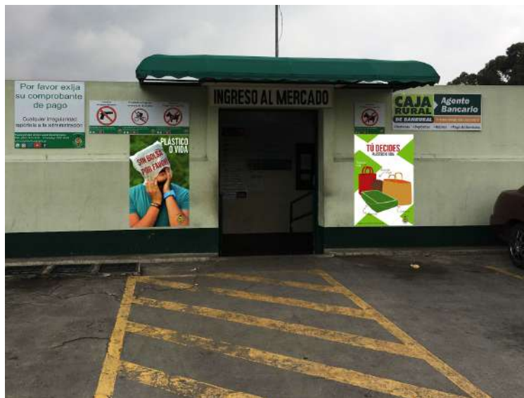
Ubicación en la entrada del parqueo al mercado municipal
