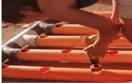
Ilustración 23 Proceso de orificios en tubería
