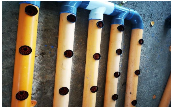
Ilustración 17 Colocación de canastillas en tubos, Huerto recirculante
