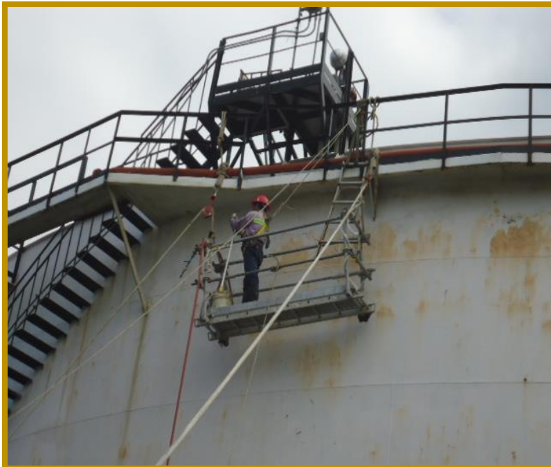
Ilustración 21 operario trabajando mantenimiento en alturas
