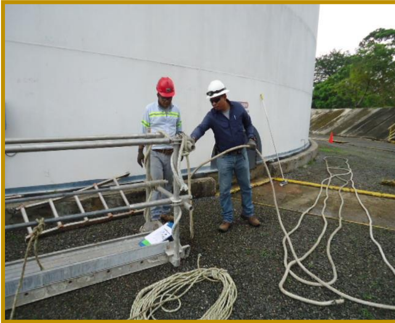
Ilustración 11 instalación de lazos y andamio
