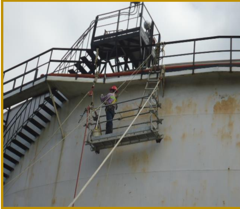
Ilustración 13 Iniciar con el mantenimiento de cepillado eléctrico con cepillos.
