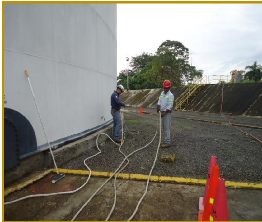
Ilustración 10 Supervisión adecuada de los trabajos por el supervisor HES SERVIMARP y CVX
