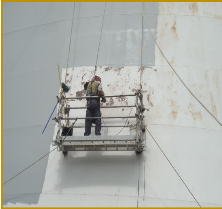
Ilustración 15 Aplicación de pintura anticorrosiva a todas las corrosiones
