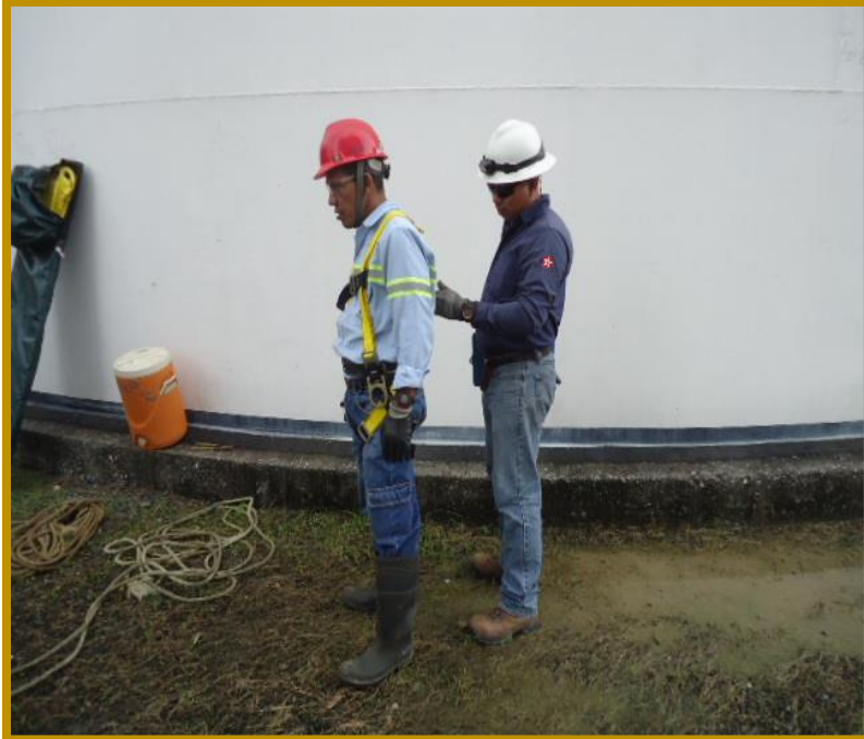
Ilustración 7 Instalar equipos; inspección de pastecas y verificar lazos a utilizar tanto de anclaje como línea de vida.
