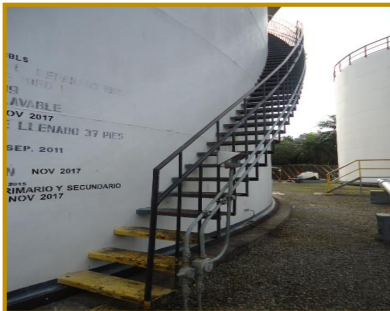
Ilustración 18 inspección para inicio de lavado de gradas
