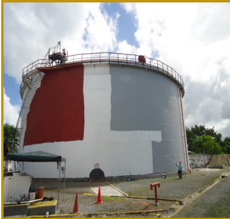
Ilustración 17 Aplicación de pintura anticorrosiva a todas las corrosiones
