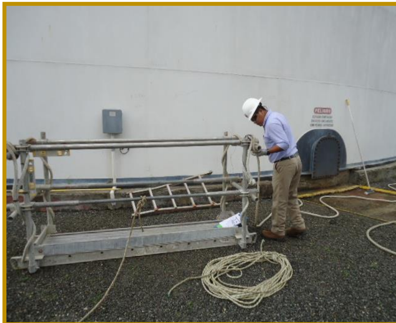
Ilustración 12 arme del andamio
