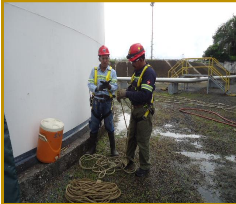
Ilustración 9 Revisión de los amarres y anclajes. (rescatista y hombre guardia, personal operativo)
